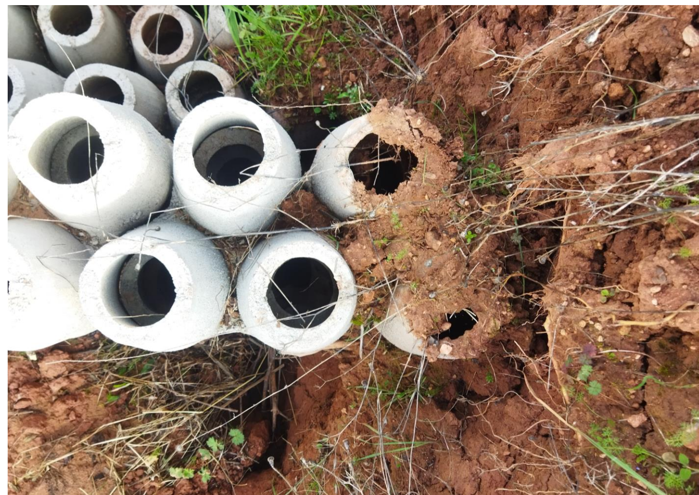
Albarrada de la serie JA-3 con estribo insuficientemente empotrado con descalce por flujo lateral
