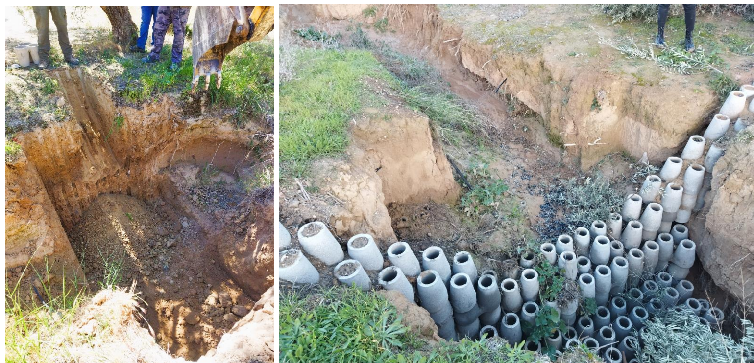
Albarrada de la serie JA-1 demasiado esbelta. La cárcava ha sido rellenada con leña que se proyectó sobre la albarrada durante una avenida
