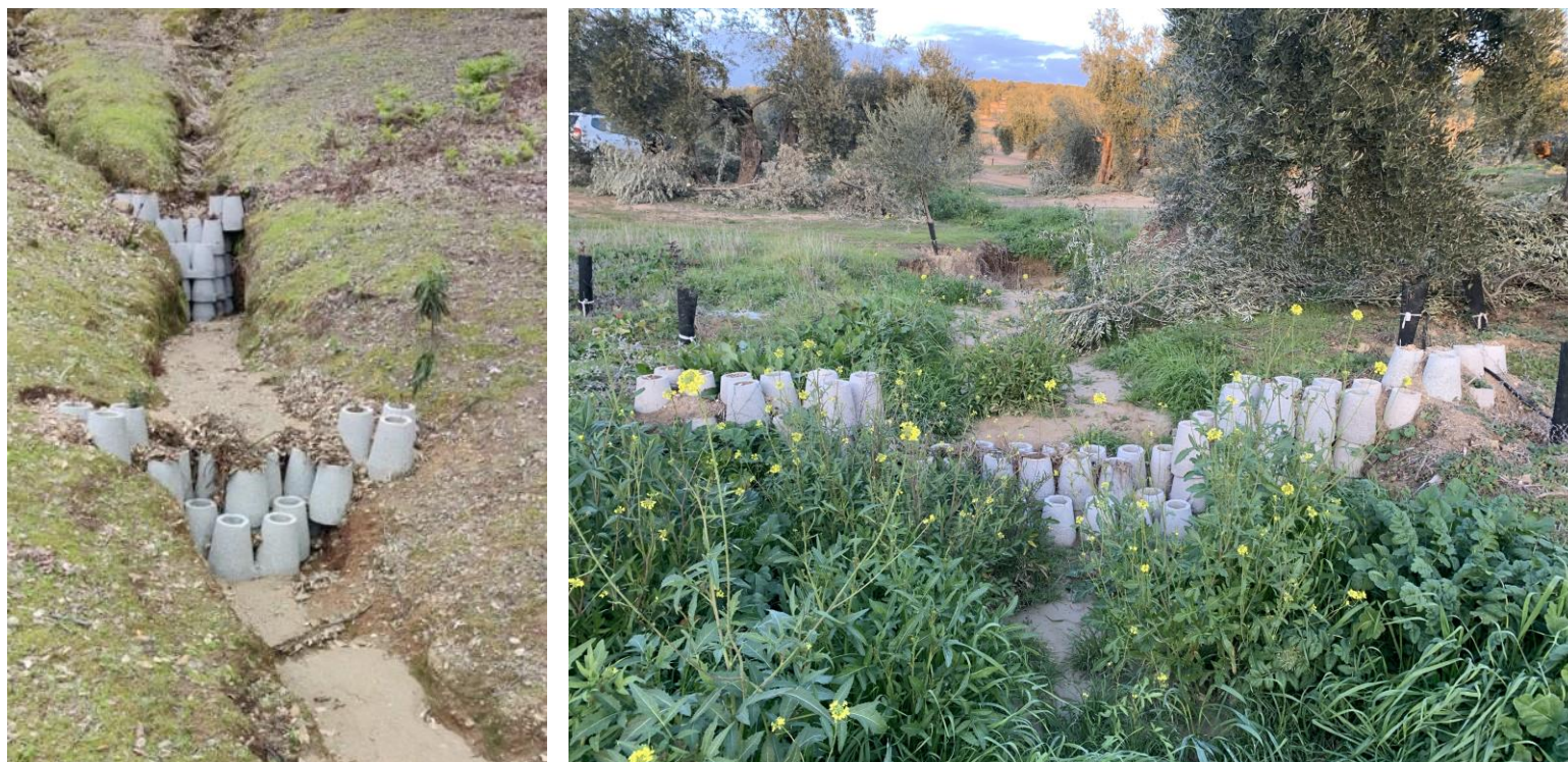
Albarrada de la serie JA-3 con estribo insuficientemente empotrado con descalce por flujo lateral
