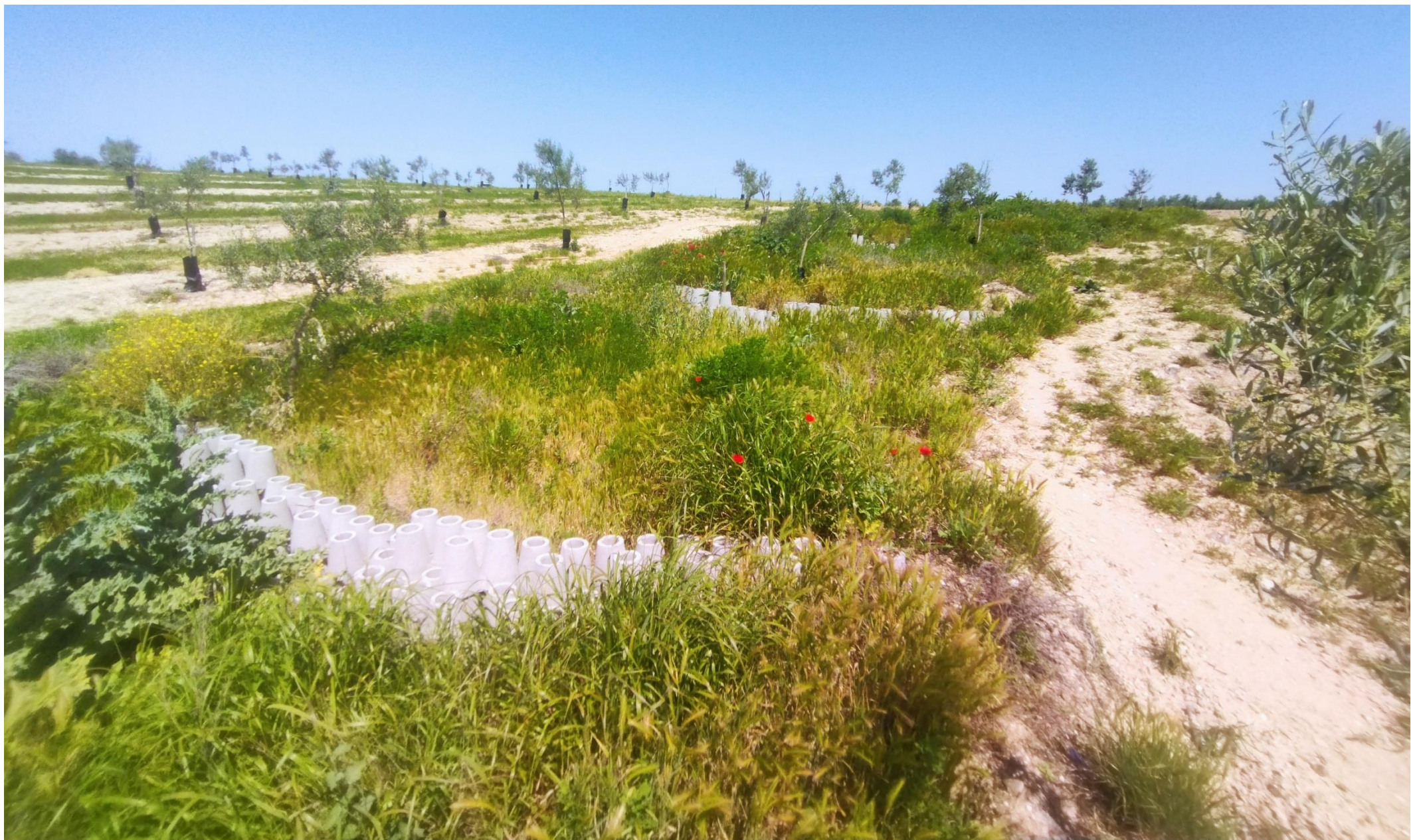
Albarrada de la serie CO-4 en abril de 2025. La revegetación de la cárcava se potencia gracias a la retención de sedimentos y humedad.
