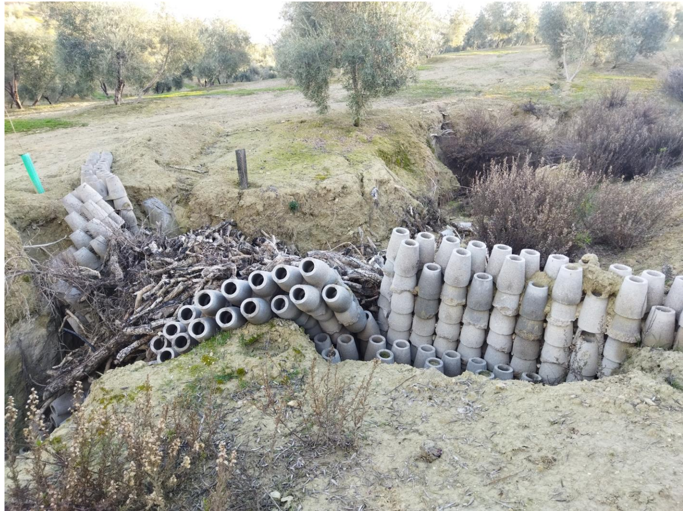
Albarrada de la serie JA-1 demasiado esbelta. La cárcava ha sido rellenada con leña que se proyectó sobre la albarrada durante una avenida
